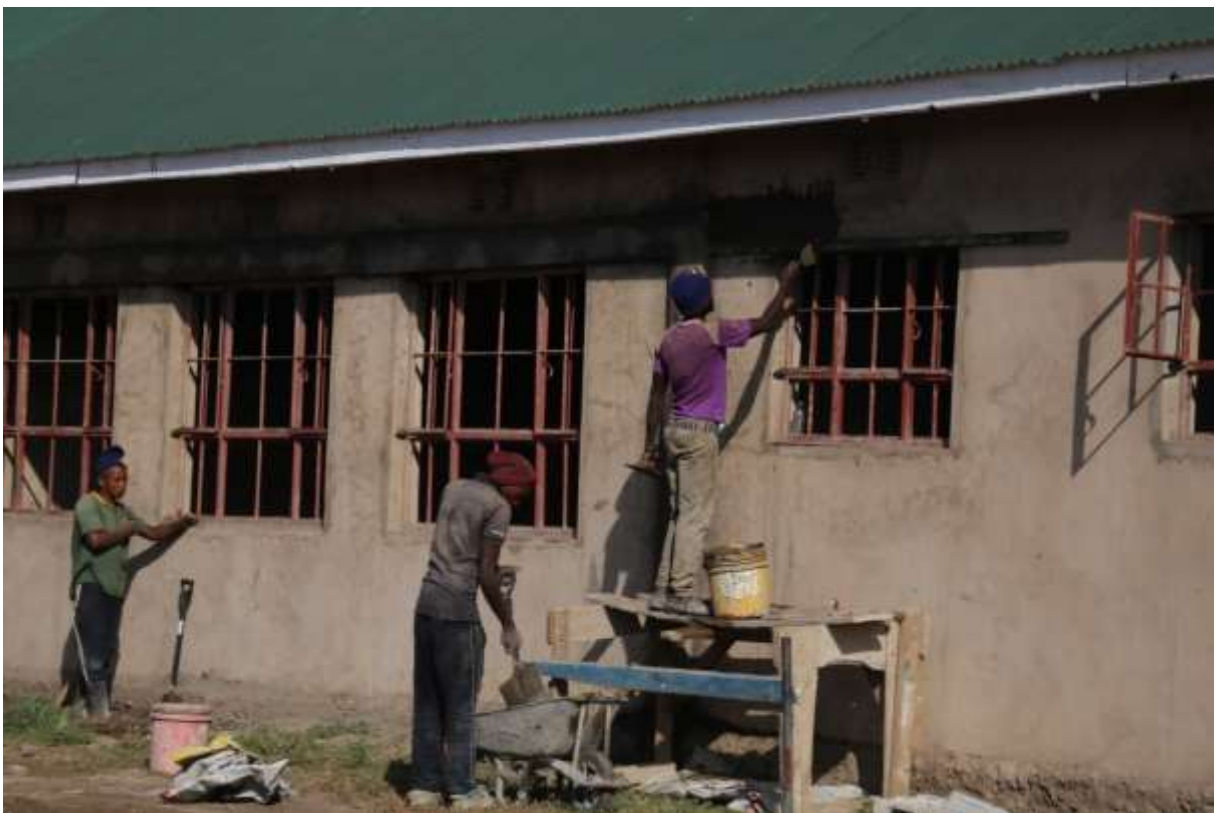
Laborkomplex: der Außenverputz ist in Arbeit
