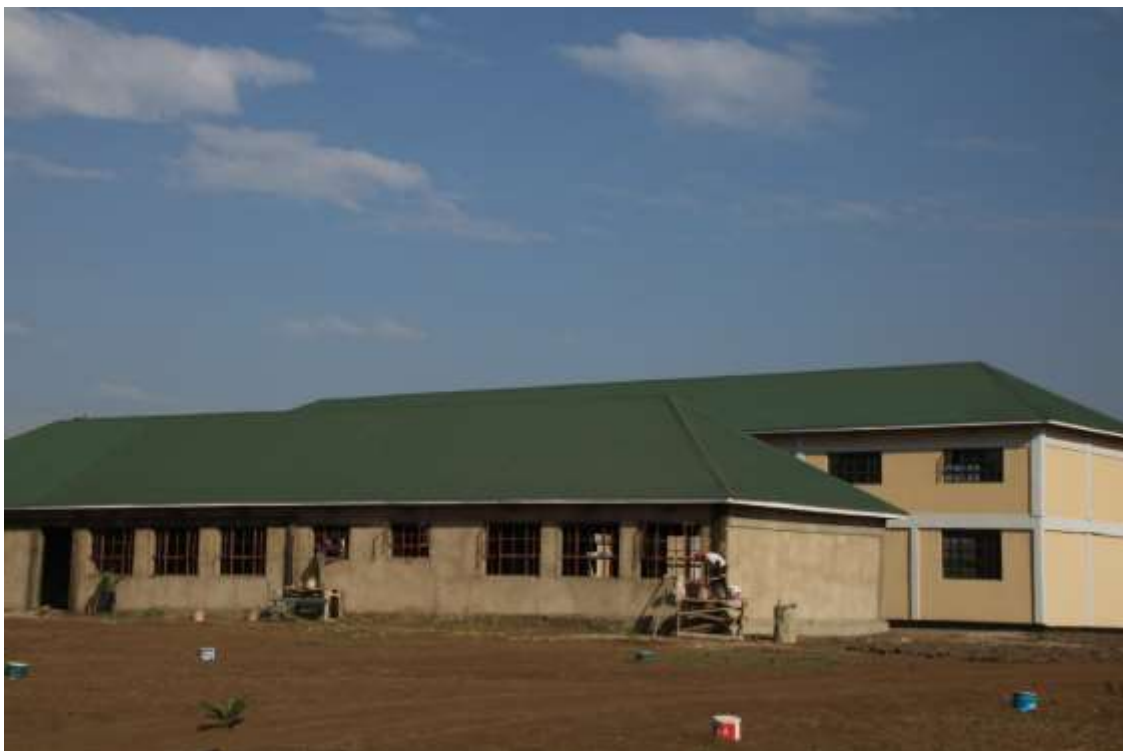
Laborkomplex und dahinter 8 Klassenräume, Rückansicht
