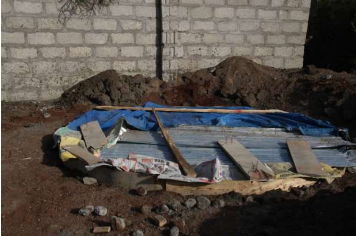
Wassertank für Vorratshaltung, Anschluss an die Militär-Wasserleitung
