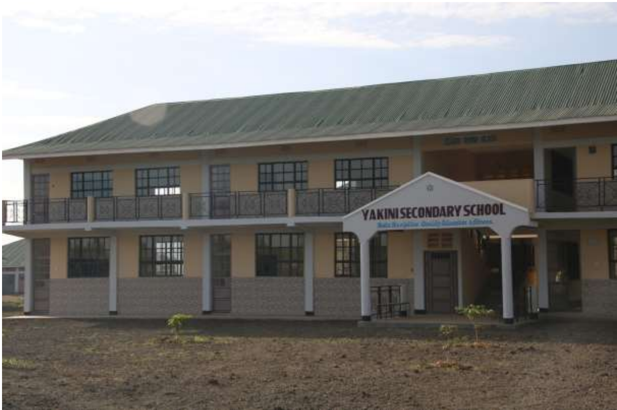
Gebäude mit 8 Schulklassen, Vorderansicht
