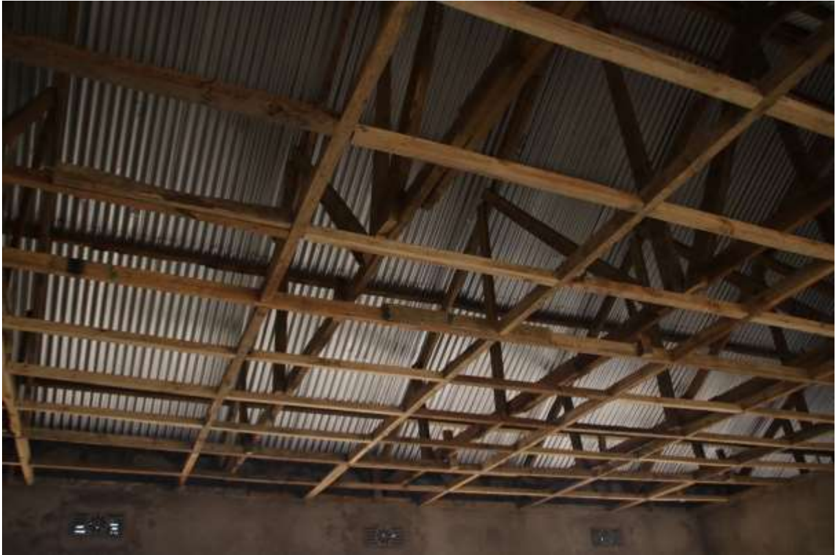
Laborkomplex: die Zwischendeckenkonstruktion ist fertig
